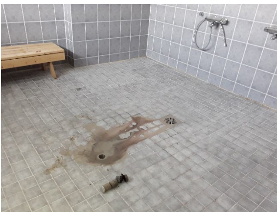
Kellarin suihkuhuoneen alapohjan avaus.
